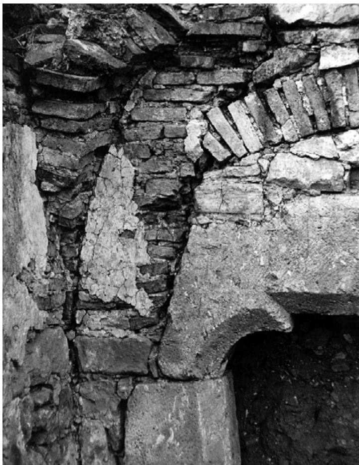
Сл. 41. Палата, детаљ портика просторије 3 са шрамом сводне конструкције трема
