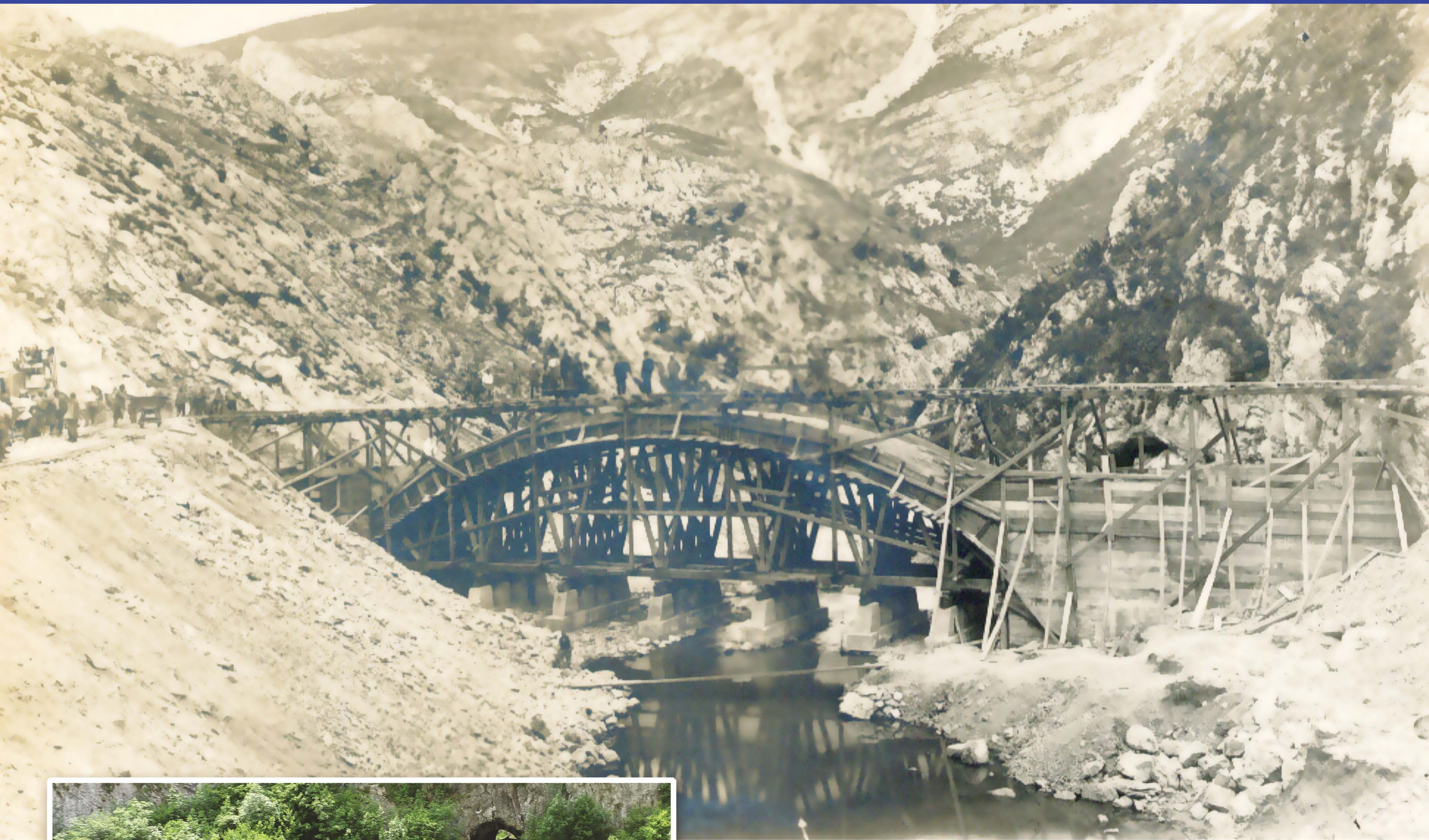
Изградња у км. 55+520, 08. август 1915.
