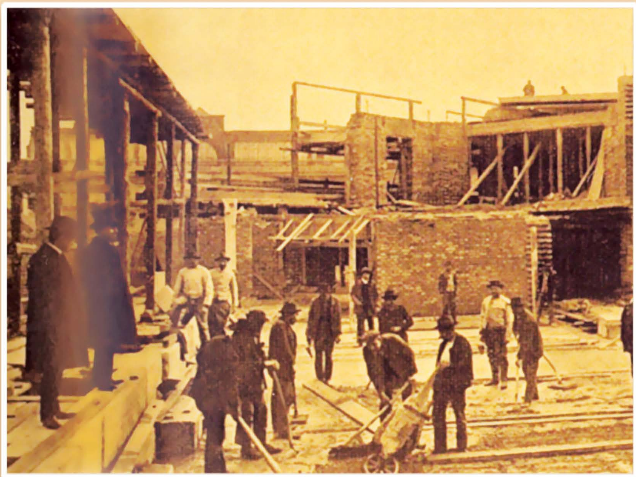
Извођење радова на таваницама по Миланковићевом систему армирања бетона
