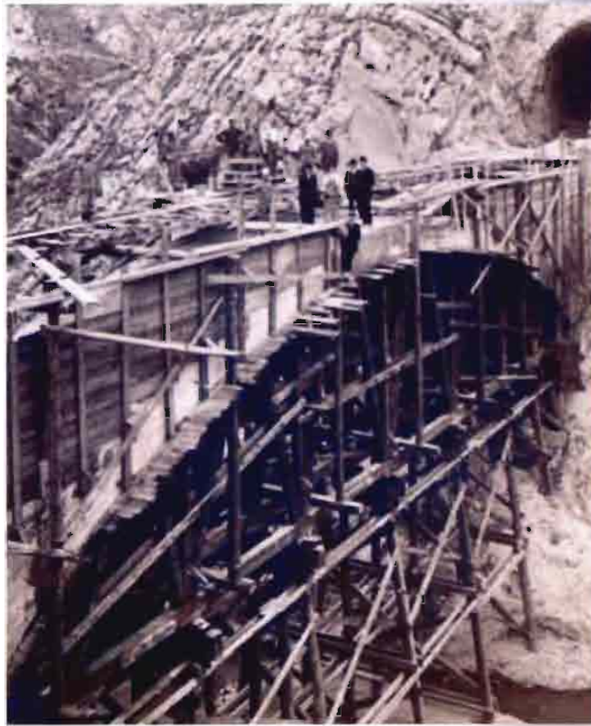
Изградња армирано-бетонског моста на прузи Ниш-Књажевац (Источна Србија) по пројекту Миланковића (Извор: Железнички музеј, Београд)
