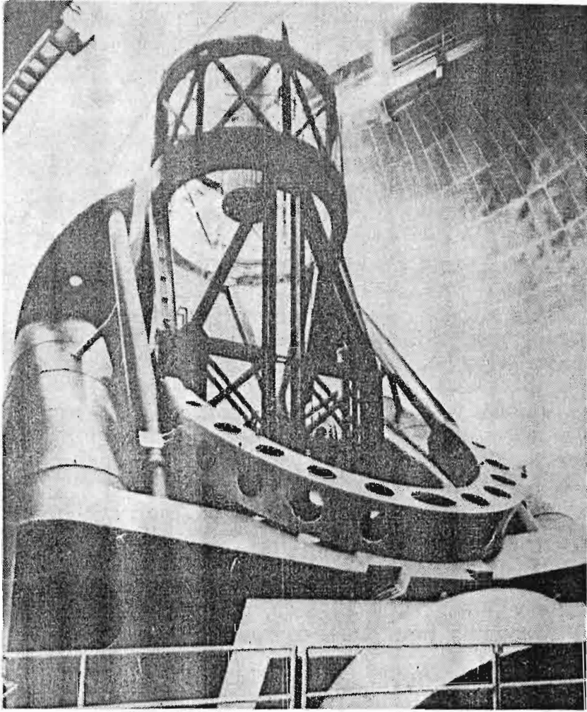
Слика 54. — Рефлектор Монт Паломарске опсерваторије у САД највећи је на свету — отвор објектива је 5 m
