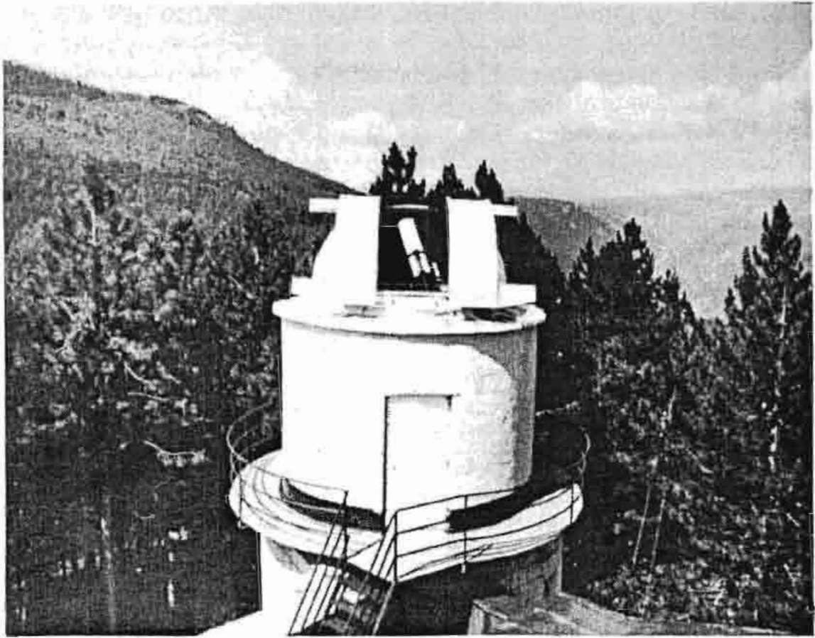
SI.181 Kupola od fiberglasa prečnika 3 m, u kojoj je bio smješten dvostruki astrograf Astronomске opservatorije u Sarajevu sa kamerama prečnika 83 mm i fokusa 375 mm.
